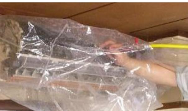
4つの分解酵素を含んだ石けん水SBSを高圧で吹付け、洗浄します。
