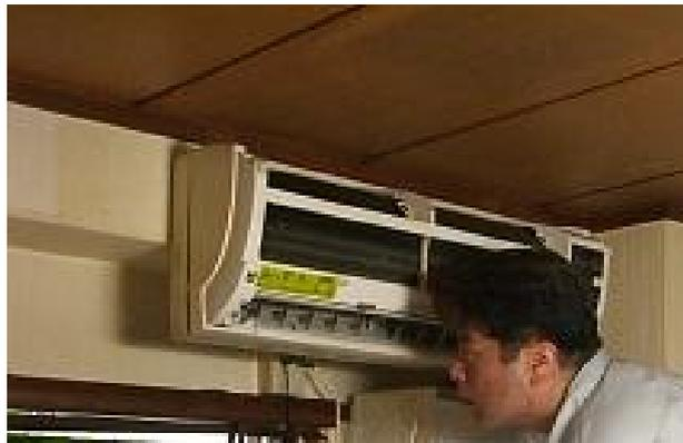
コンセントを抜き、前面グリルを開き・エアフィルターをはずします。
