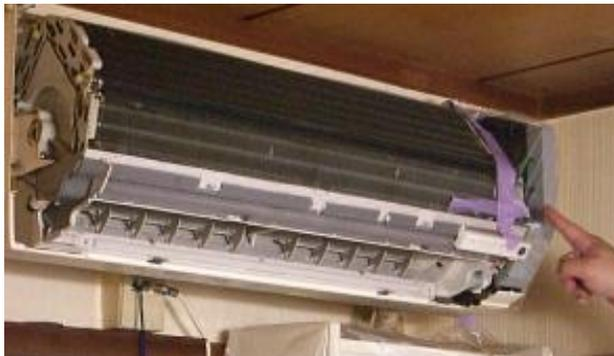
前面グリルをはずし、液ダレしないようにポリフィルムで養生をします。
