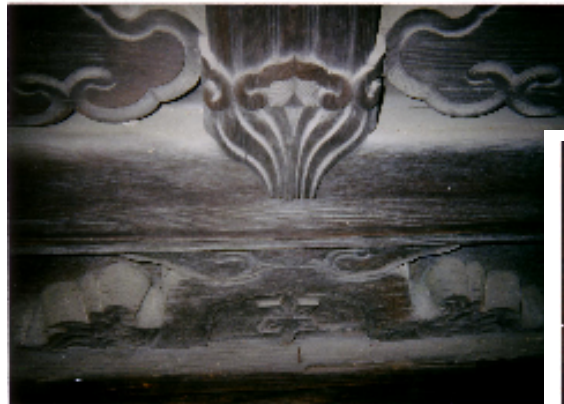
施工例② 600年程前に建立された寺院
